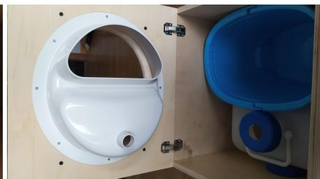
17. Loch mit Kreisschneider entsprechend dem verwendeten Dichtmittels verwenden. Bei meinem Geruchsverschluss sind es 35mm bei z. B. eines Gumminippels auf dem Baumarkt 30/40mm sind es 38mm aber bitte erst den Außendurchmesser genau messen, da jeder anders sein kann und nicht auf die Normmaße verlassen. Den Deckel des 10L Urinkanisters einen Hauch aufdrehen, damit die Luft beim
